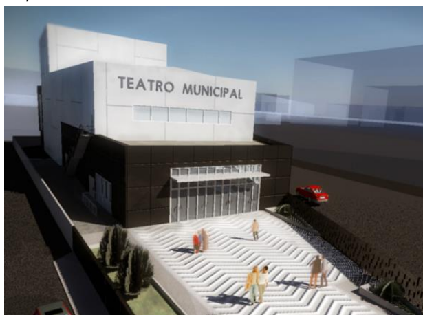
Nuevo teatro municipal (en fase de ejecución)
